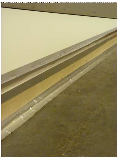
Photo 3 : pose de scotch aluminium pour montage de type E-100
