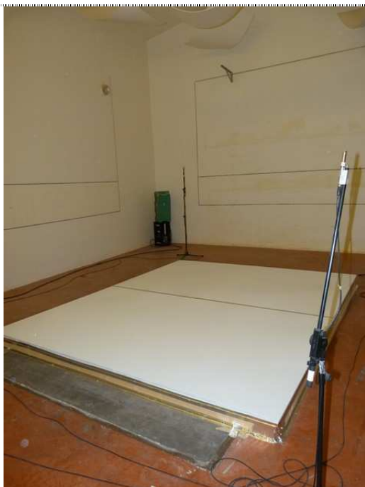
Photo 1 : montage des dalles
