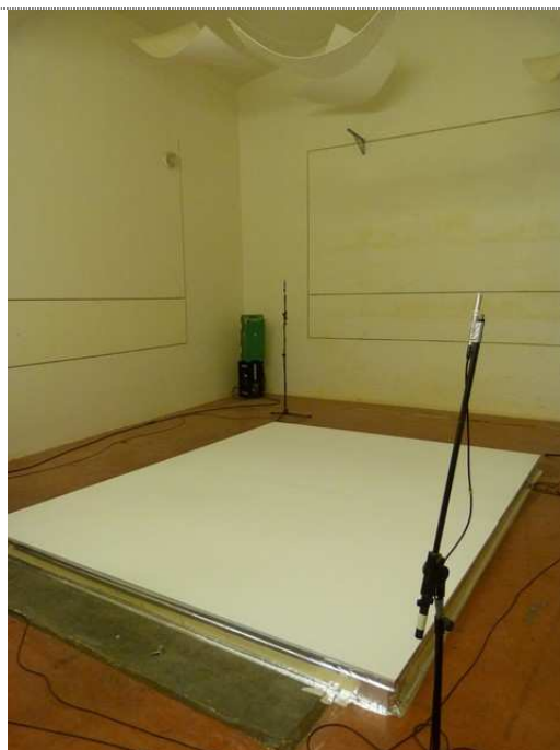
Photo 2 : montage des plafonds
